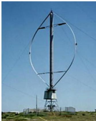
Fig. 7 – Éolienne de type Darrieus.
